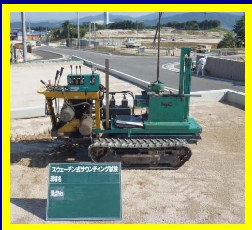
地盤調査風景
